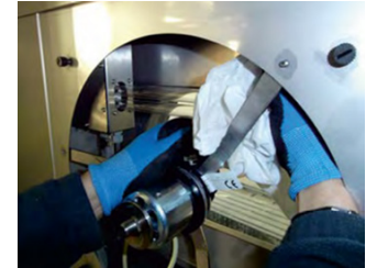
Czyszczenie silnika i komory wywiewnej filtra
