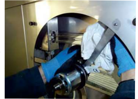
Czyszczenie silnika i komory wywiewnej filtra
